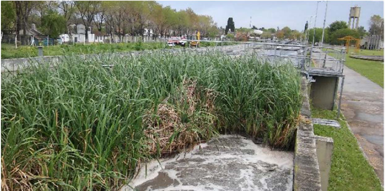
Figura 14: Juncos en la Zanja de oxidación
