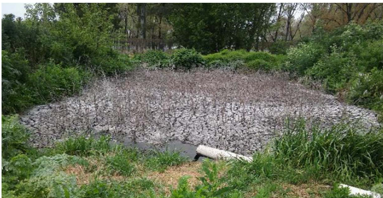
Figura 17: Laguna de almacenamiento de barros sin barrera impermeable
