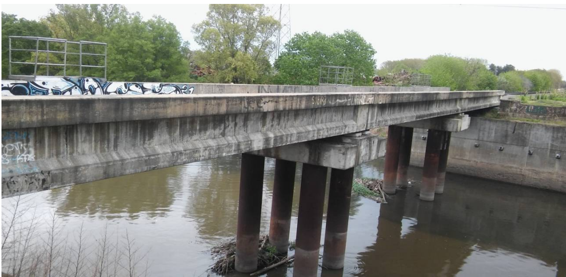
Figura 21: Cuerpo Receptor de Efluentes de Planta Depuradora. Aguas Arriba. Río Reconquista.
