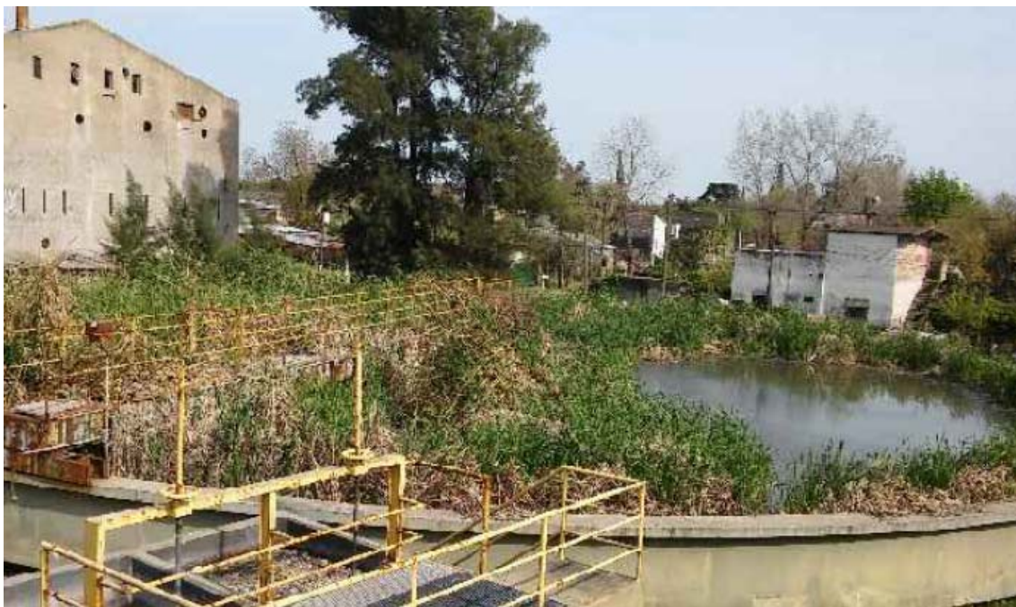
Sedimentador secundario con puente barredor roto y presencia de arbustos
