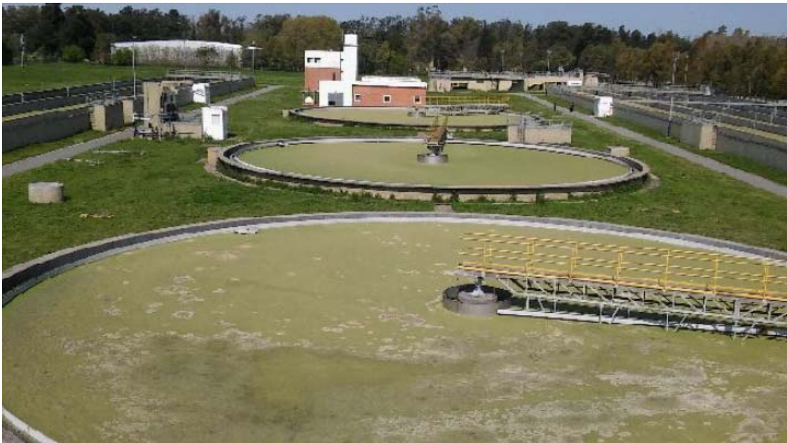
Sedimentador secundario con barros y flotantes
