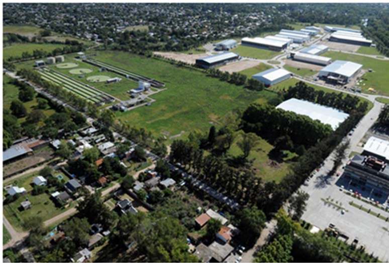
Figura 1: Vista aérea de la Planta Depuradora Las Catonas y su entorno inmediato.
