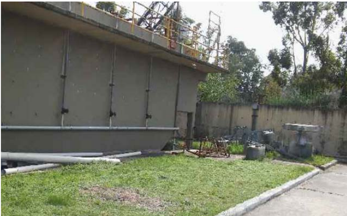
Residuos sólidos y aireadores en Desarenador
